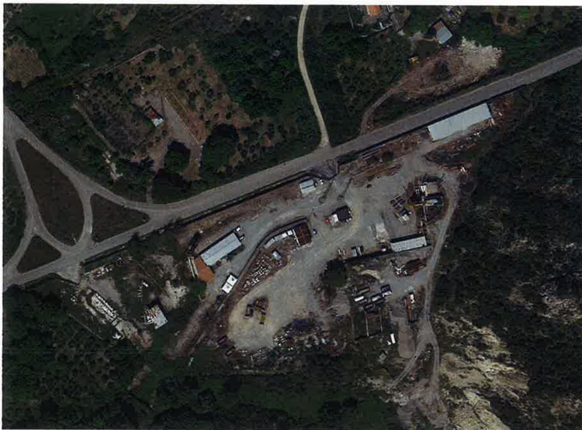
Disegno 2 – Ortofoto aerea Valsinni - cantiere
